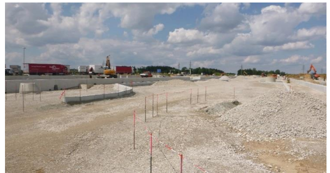
Abb. 16: Einbau RC Beton [Ettengruber]
