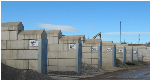
Abb. 10: Blocksteine aus Recycling-Beton für Schüttgutboxen [Mettke]
