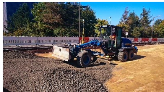
Abb. 20: Einbau Frostschutzschicht [SÖR]
