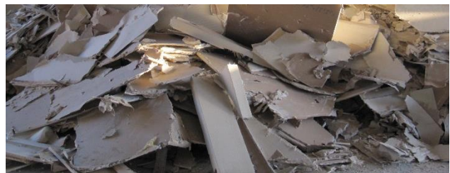
Abb. 13: Selektierte Gipskartonplatten sind getrennt zu halten und sollten nicht mit Porenbeton vermischt werden [Mettke]
