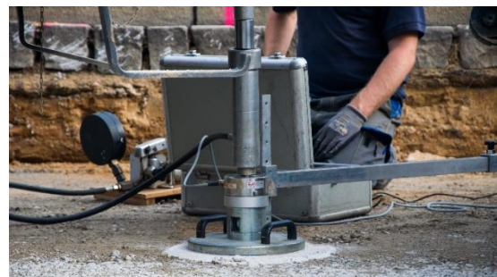
Abb. 21: Prüfung der Frostschutzschicht [SÖR]
